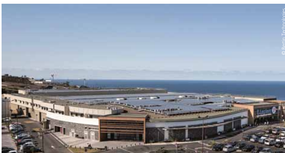
Ferme photovoltaïque de Saint-Leu (Île de la Réunion)
